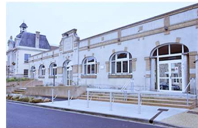
Rénovation de l'éclairage intérieur (led)
