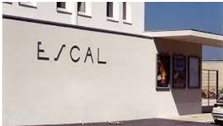
Rénovation des salles de musique
